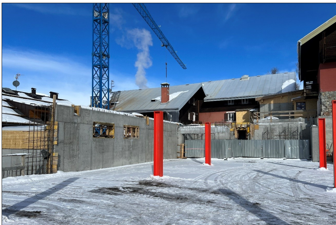
Foto.4- Terzo livello dell'autorimessa in corso di realizzazione.
