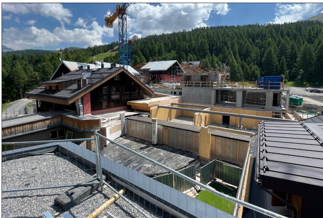
Foto.6- Vista volumi centrali in corso di realizzazione.
