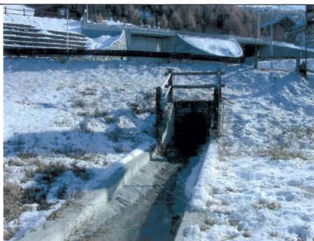
Foto 14 Sblocco a valle della S.S. 301 (attraversamento alto).
