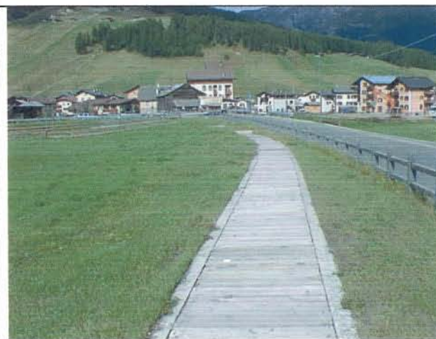
Foto 28 Tratto canalizzato lungo via Marangona con copertura in legno rimovibile
