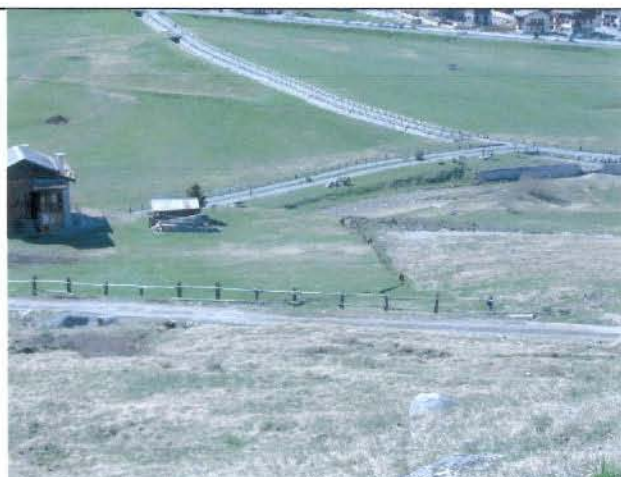
Foto 229 Tratto d'alveo a valle della pista ciclabile alta con attraversamento di strada privata.
