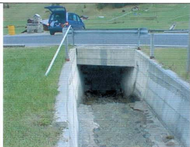
Foto 13 Imbocco attraversamento via Flòrìn
