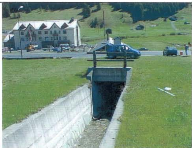
Foto 26 Imbocco tratto tombato sotto via Sàròch e via Fréita
