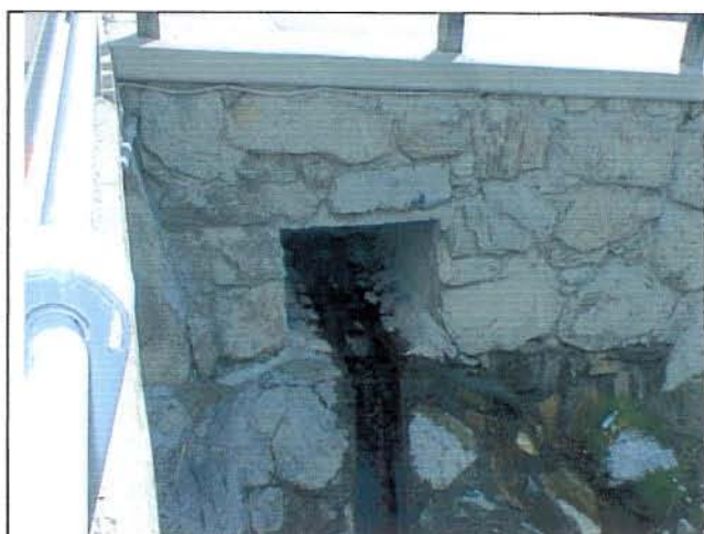
Foto 29 Sbocco nello Spöl (vista dal ponte di via Pemont)
