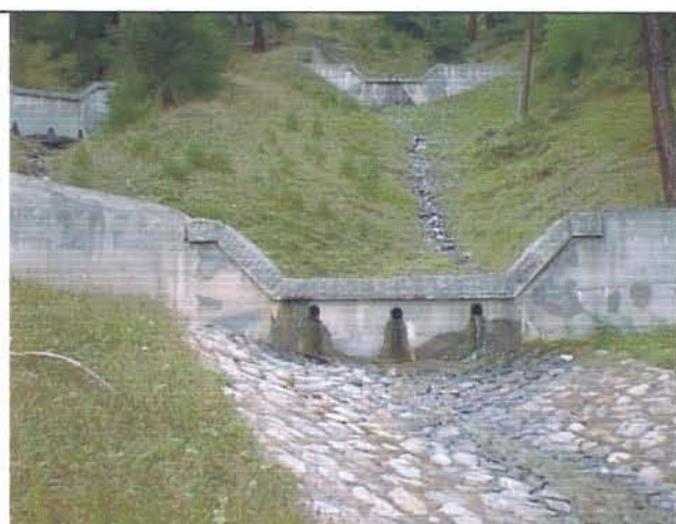
Foto 14 (fuori planimetria) Sistema di briglie a monte del proseguimento di via Marangona sul ramo destro
