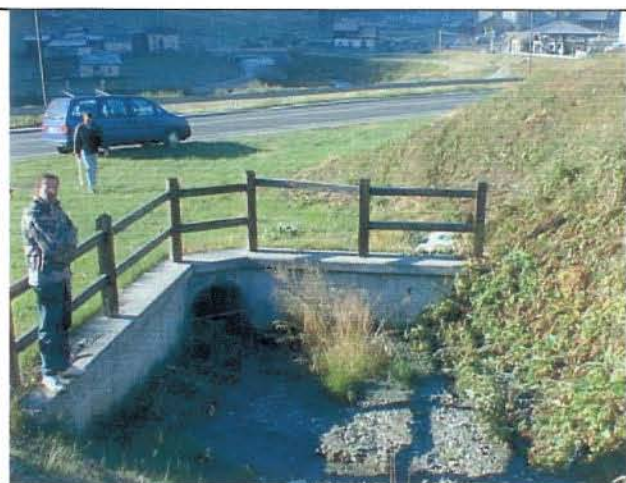
Foto 1 Imbocco tombamento via Bòrch (si nota l'accumulo di materiale)
