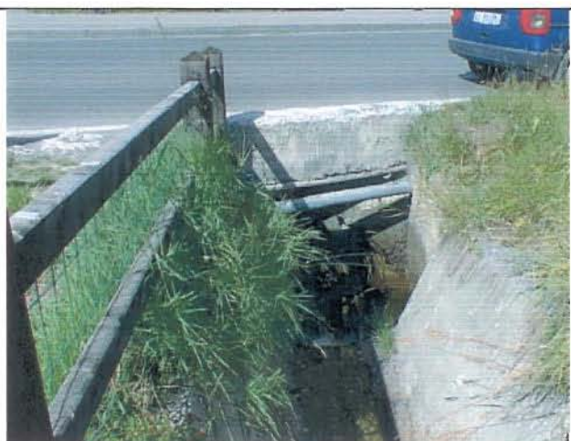
Foto 26 Imbocco del secondo tratto tombato
