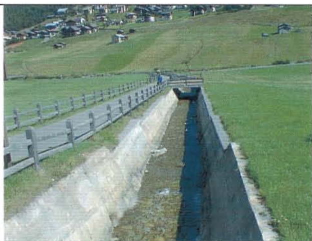
Foto 23 Tratto canalizzato da via tra via Pedrana-Vinécc e la confluenza nello Spöl
