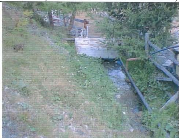
Foto 8 Ultimo tratto a cielo aperto prima del tratto tombato
