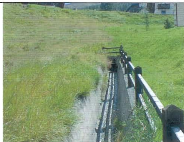
Foto 25 Tratto canalizzato allo sbocco del primo tombamento
