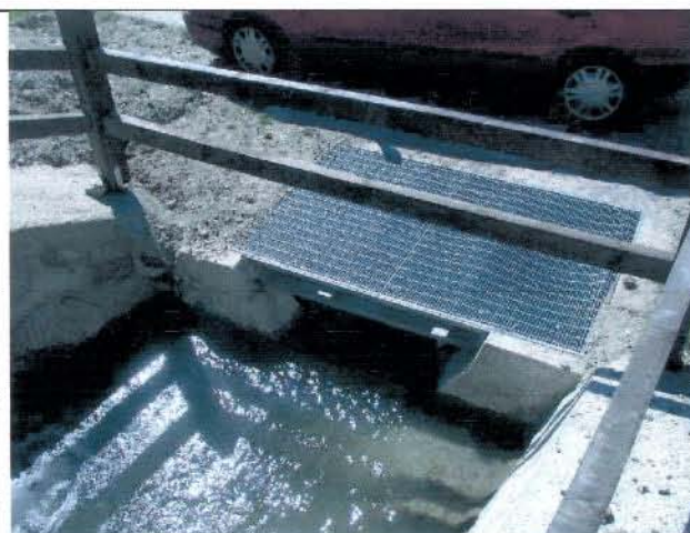
Foto 221 Particolare manufatto di imbocco attraversamento pista ciclabile alta.
