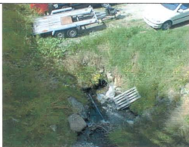
Foto 19 Imbocco dell'ultimo tratto tombato
