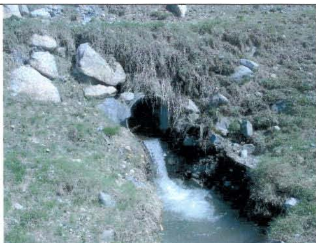
Foto 217 Sbocco pista ciclabile alta.
