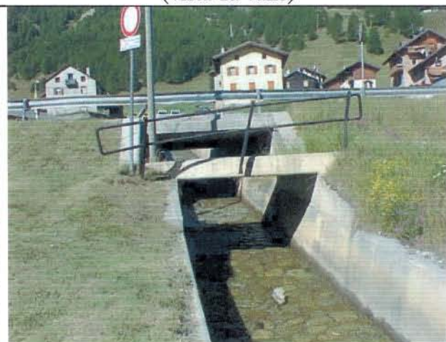
Foto 19 Tombotto di attraversamento di via Bòrch (vista da valle)
