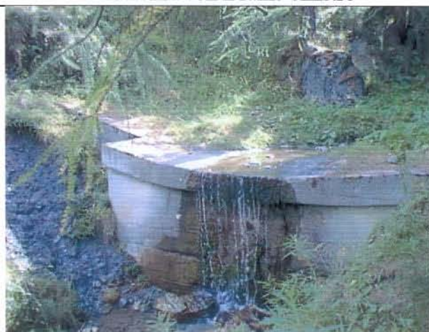
Foto 22 Ramo sinistro: briglia a monte dell'inizio del tratto canalizzato
