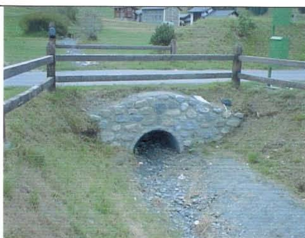
Foto 2 Attraversamento pista ciclabile (vista da valle)
