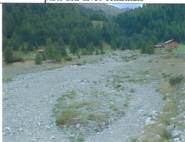
Foto 14 Vista dell'alveo dal ponte di via Compàrt verso monte
