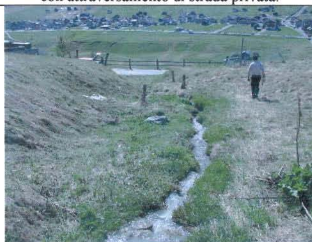
Foto 231 Tratto d'alveo a valle della S.S. 301 (attraversamento basso).
