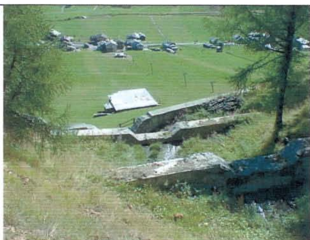
Foto 22 Ultime briglie al termine del bosco
