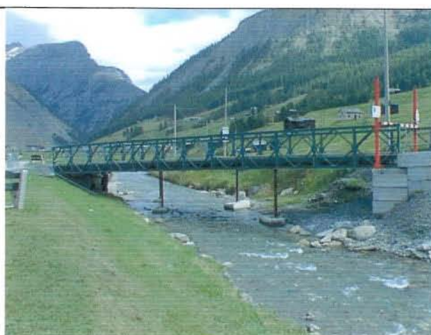
Foto 2 Ponte provvisorio a valle dello sbocco
