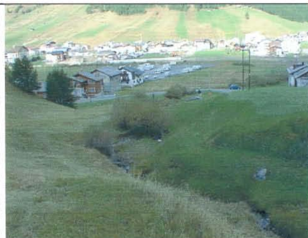
Foto 9 Bacino medio a monte di via Pemont (vista verso valle)
