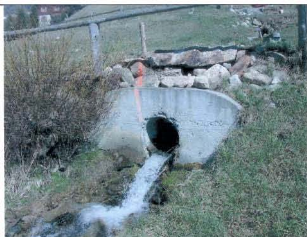
Foto 220 Sbocco attraversamento via privata.
