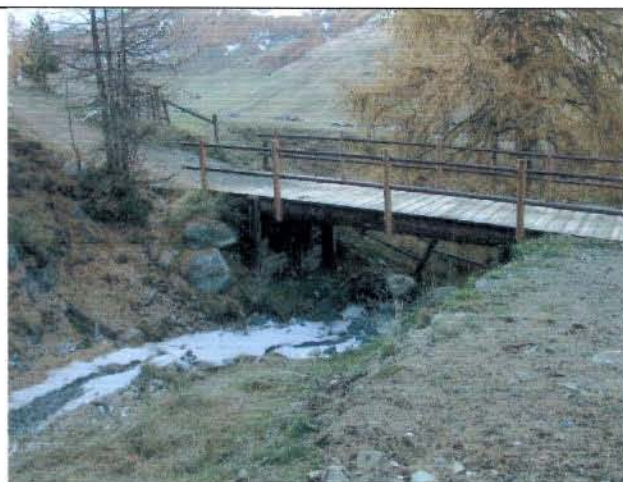
Foto 13 Ponte più a monte tra i due laterali di via dali Stròzia (vista da monte)
