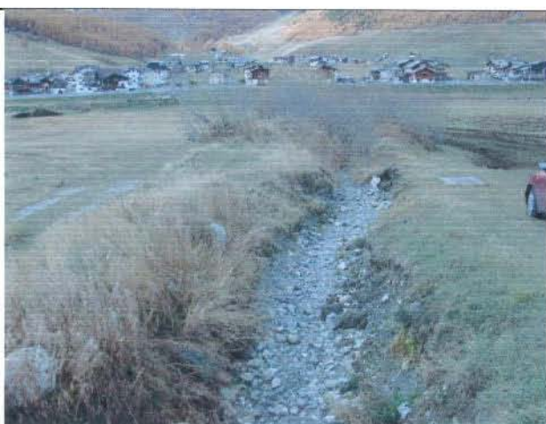
Foto 6 Primo tratto a valle di via Pemont (di recente eliminato un manufatto di restringimento)
