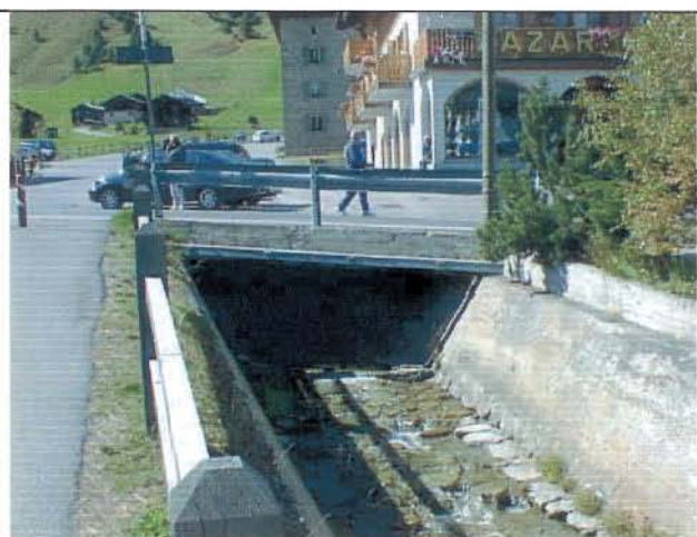
Foto 20 Ponte via Sàroch (vista da valle)
