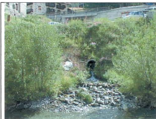
Foto 17 Sblocco dell'ultimo tratto tombato nello Spöl
