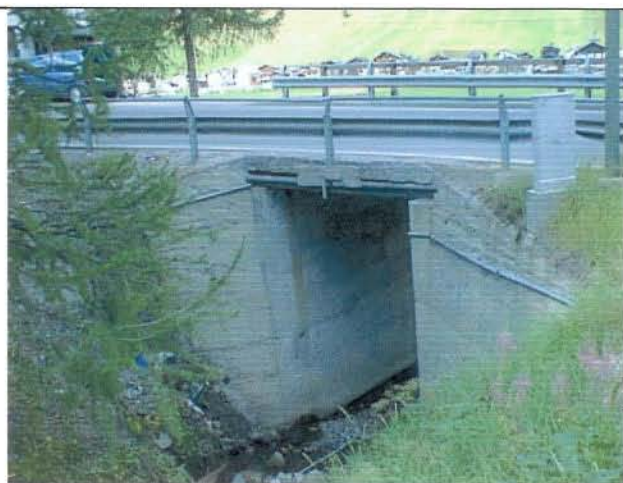
Foto 11 Ponte SS. 301 (vista da monte)
