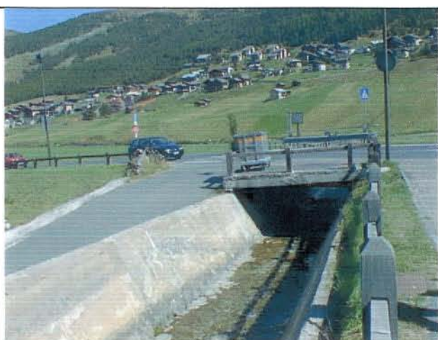
Foto 21 Ponte via Pedrana-Vinécc (vista da monte)
