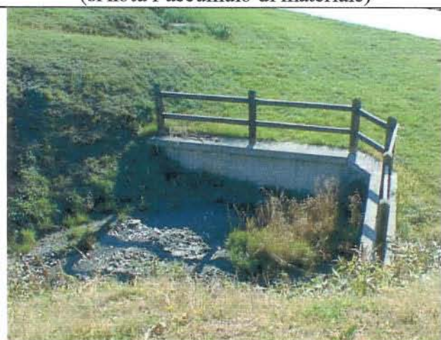
Foto 3 Imbocco tombamento via Bòrch (si nota l'accumulo di materiale)
