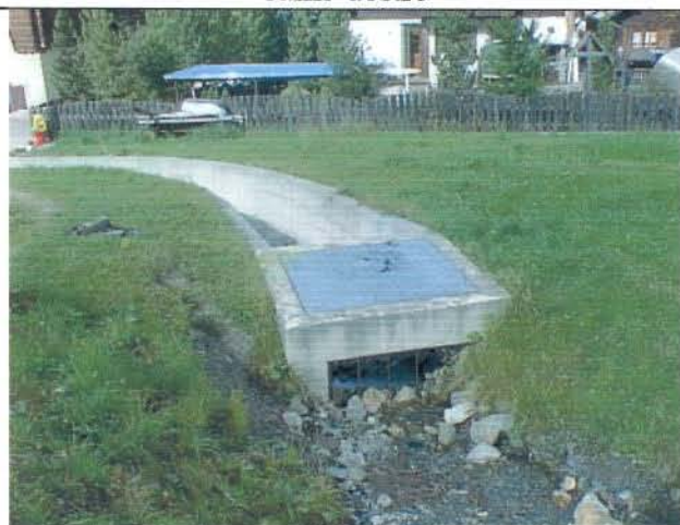
Foto 19 Ramo destro: inizio del tratto canalizzato con griglia grossolana di trattenimento materiale
