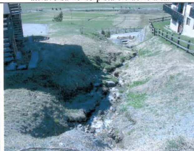
Foto 238 Tratto d'alveo a valle dello sbocco del secondo attraversamento della S.S. 301.
