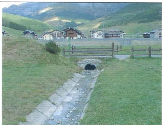
Foto 3 Attraversamento pista ciclabile (vista da monte)
