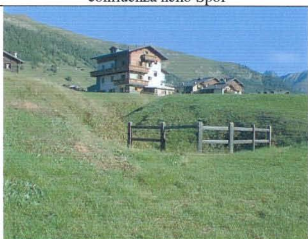
Foto 4 Imbocco tombamento via Bòrch da valle (si nota la scarsa incisione dell'alveo a monte)
