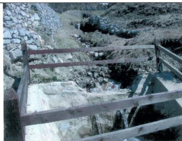
Foto 222 Tratto d'alveo a monte del manufatto di imbocco attraversamento pista ciclabile alta.
