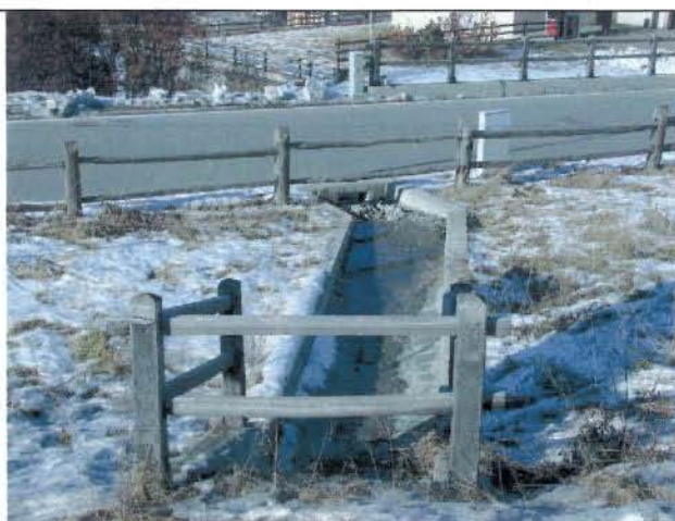
Foto 15 Imbocco tombotto via Téola.
