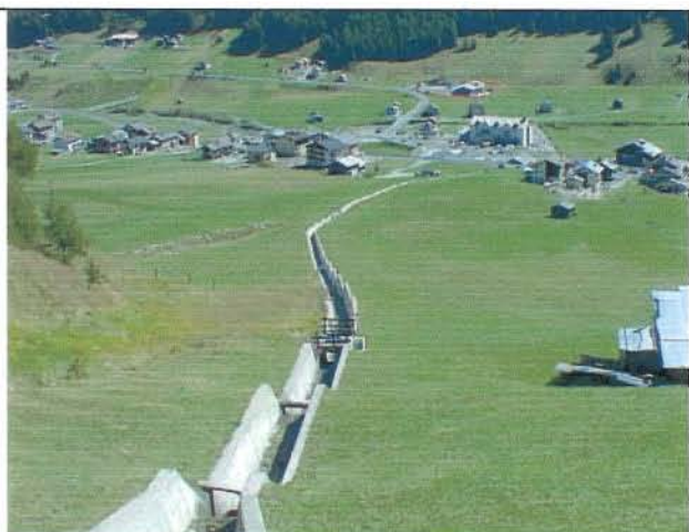
Foto 24 Tratto canalizzato dall'ultima briglia verso valle
