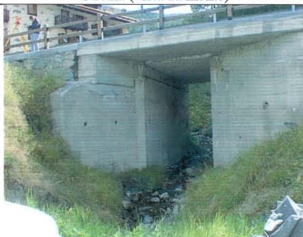
Foto 16 Ponte SS. 301 (vista da valle)
