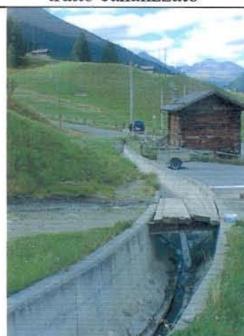
Foto 20 Ramo destro: tratto canalizzato a monte della confluenza con il ramo sinistro
