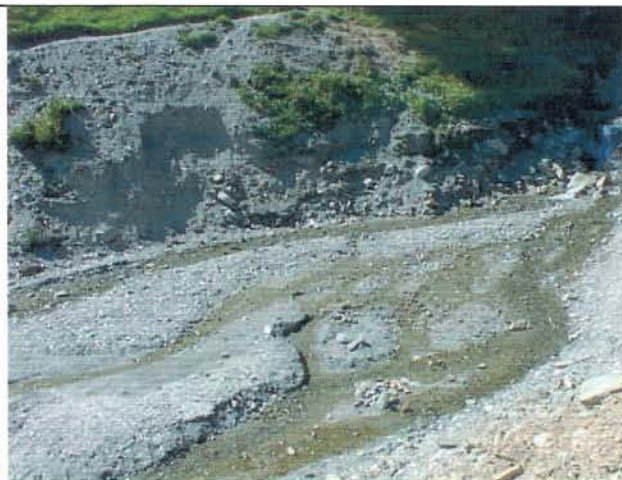
Foto 3 Interrimento della prima briglia del sistema di tre briglie al termine del tratto boschivo
