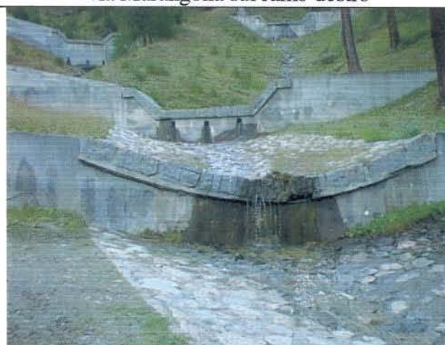
Foto 15 (fuori planimetria) Sistema di briglie e guado sul proseguimento di via Marangona sul ramo destro
