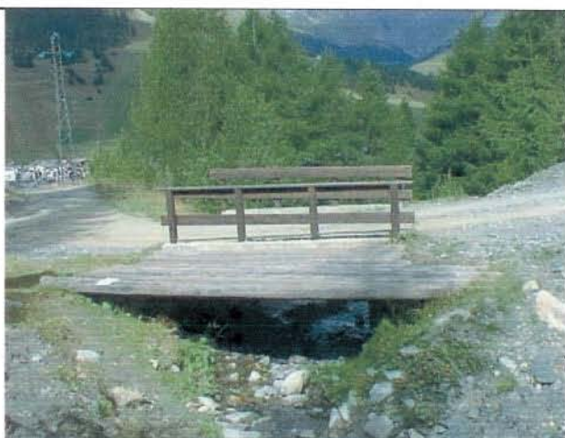
Foto 9 Ponte su via Corta (vista da monte)
