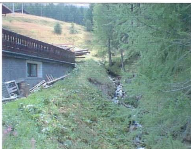
Foto 12 Tratto d'alveo a monte del ponte SS. 301
