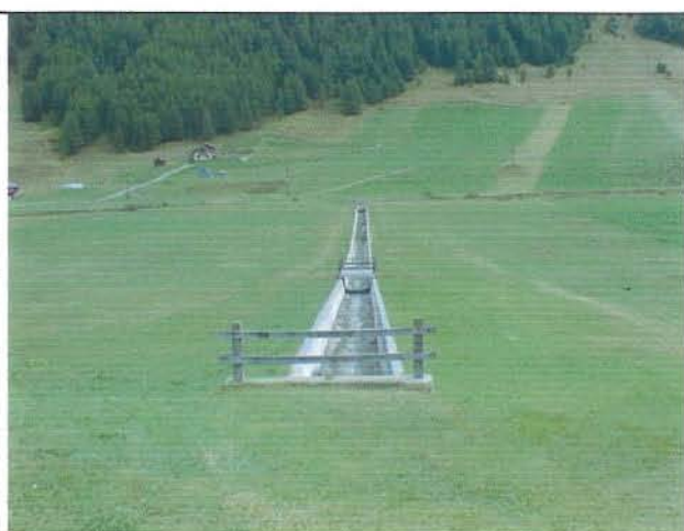
Foto 14 Sbocco a valle di via Flòrìn e tratto canalizzato fino allo Spöl
