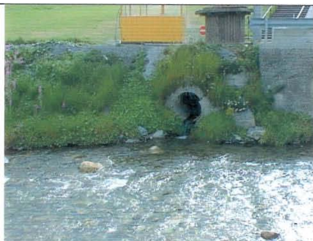
Foto 1 Sbocco del tratto tombato nello Spöl
