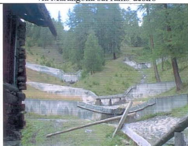
Foto 16 (fuori planimetria) Vista d'insieme del sistema di briglie e guado sul ramo destro
