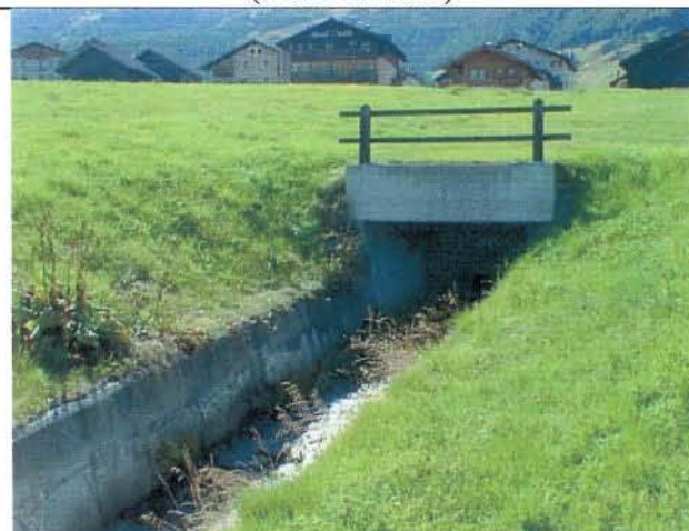
Foto 29 Sbocco tratto tombato a monte di via Còntin
