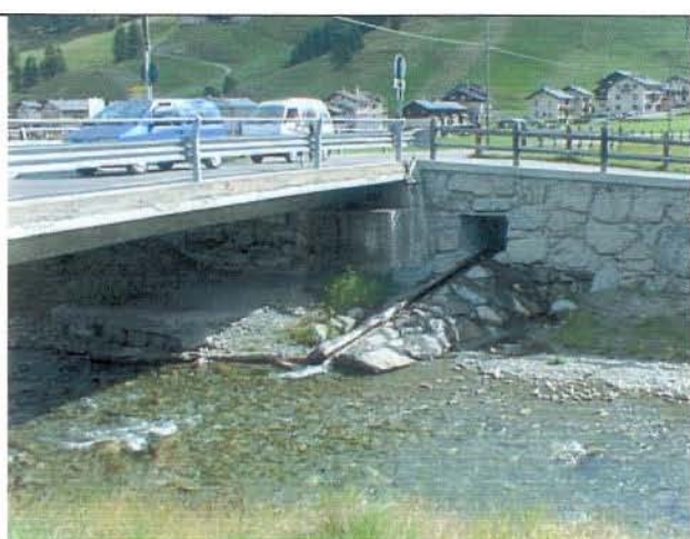
Foto 30 Sbocco nello Spöl con scivolo di magra (vista da via Li Pont)
