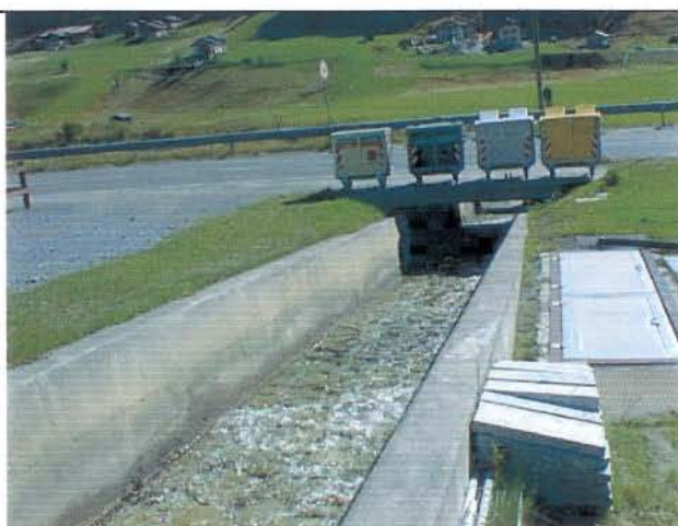
Foto 18 Tombotto di attraversamento di via Bòrch (vista da monte)
