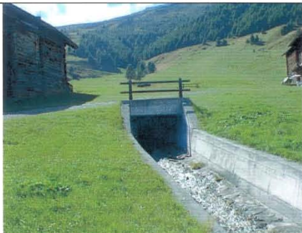
Foto 27 Ponte all'inizio del tratto canalizzato (vista da valle)
