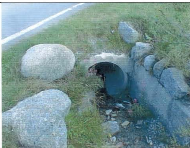
Foto 8 Attraversamento via Pemont (vista da monte)
