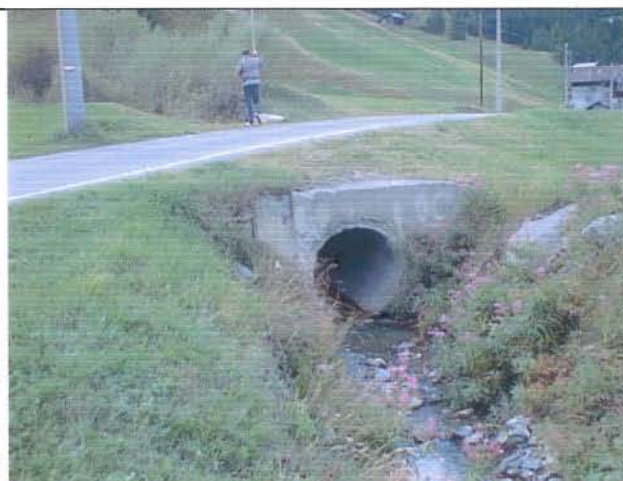
Foto 7 Attraversamento via Pemont (vista da valle)
