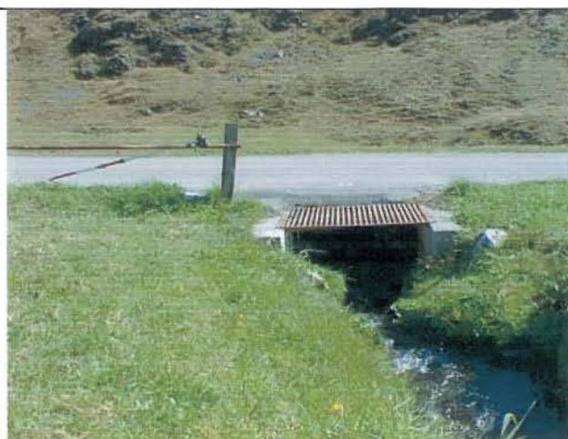
Foto 12 Imbocco del tombotto di via dali Croscéta
