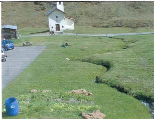
Foto 29 Tratto d'alveo tra via Présòt e via dali Croscéta (vista da monte)
