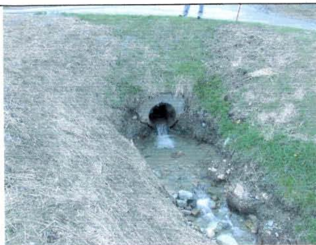
Foto 54 Tombotto di attraversamento di via Plan (vista da valle)
