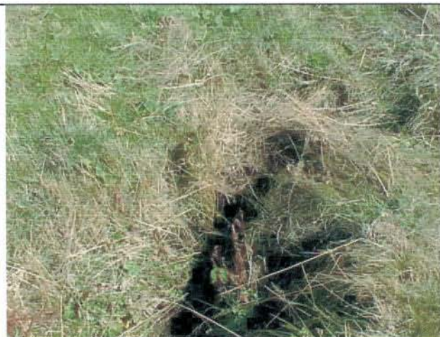
Foto 10 Imbocco del tombotto di via dali Croscéta con griglia (occultata alla vista dalla vegetazione)
