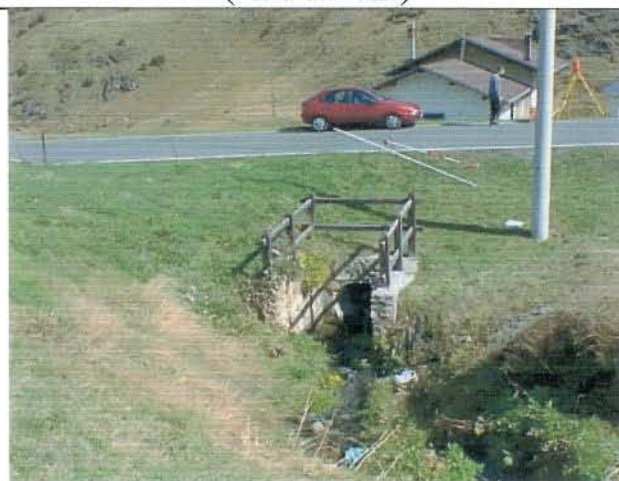
Foto 27 Imbocco del tombotto di via Présòt (visione d'insieme)
