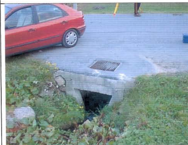
Foto 74 Imbocco tombotto via Stèfan
