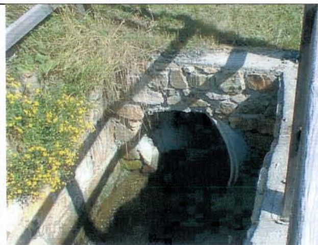
Foto 26 Imbocco del tombotto di via Présòt (dettaglio)
