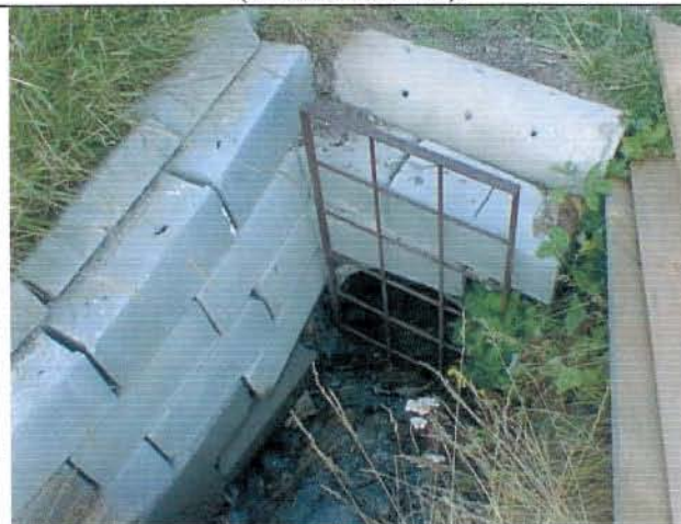
Foto 39 Imbocco del tombotto della SS. 301
