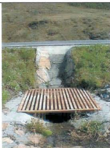
Foto 22 Imbocco del tombotto di via Présòt (dettaglio)
