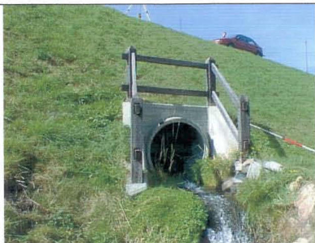
Foto 28 Sbocco del tombotto di via Présòt
