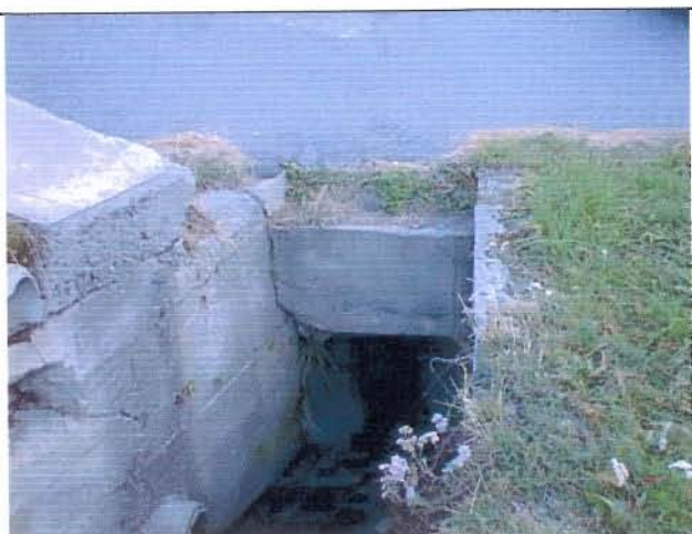
Foto 70 Imbocco tombotto via Ross
