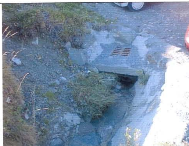
Foto 86 Imbocco ramo secondario al tombotto della SS 301
