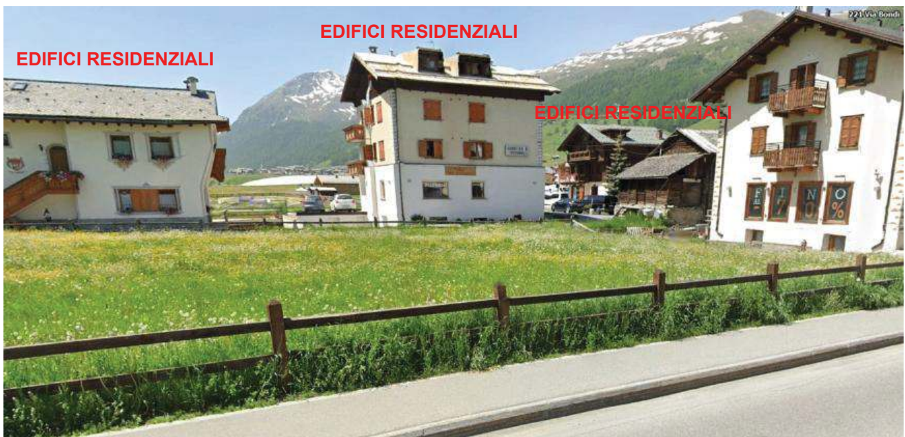
Fig.3 – Edifici residenziali lato est
