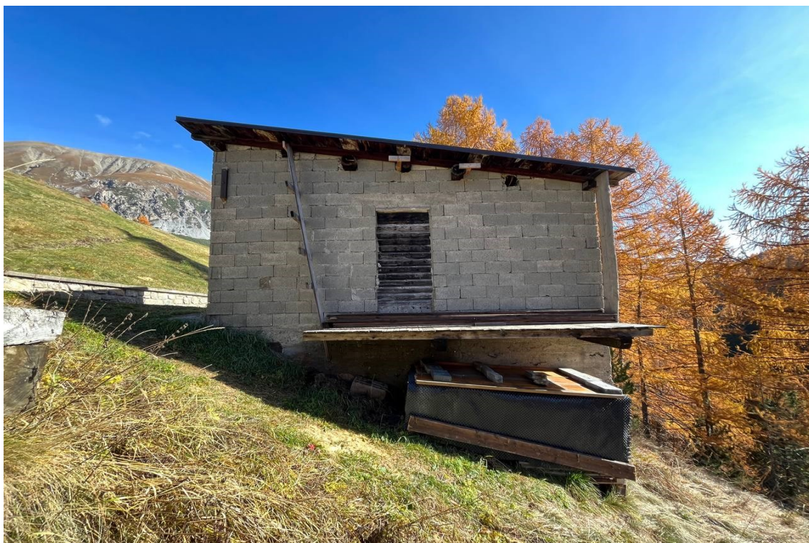
VISTA GENERALE SU PROSPETTO OVEST
