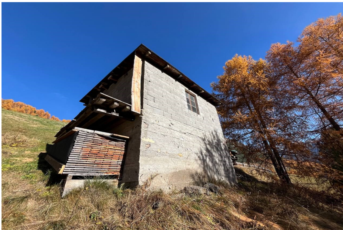
VISTA GENERALE SU PROSPETTO SUD
