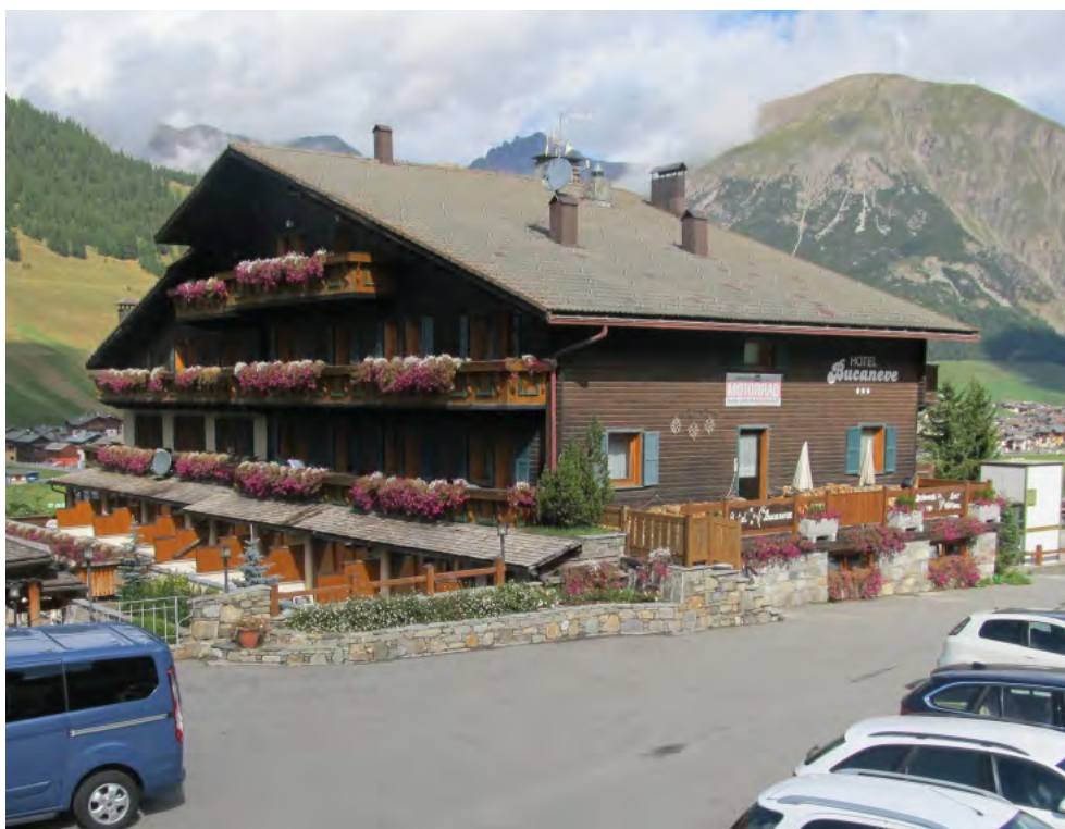
Vista del Prospetto Sud - Est
