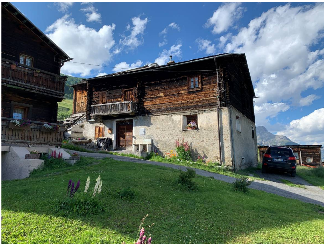
vista da sud del fabbricato oggetto d'intervento
