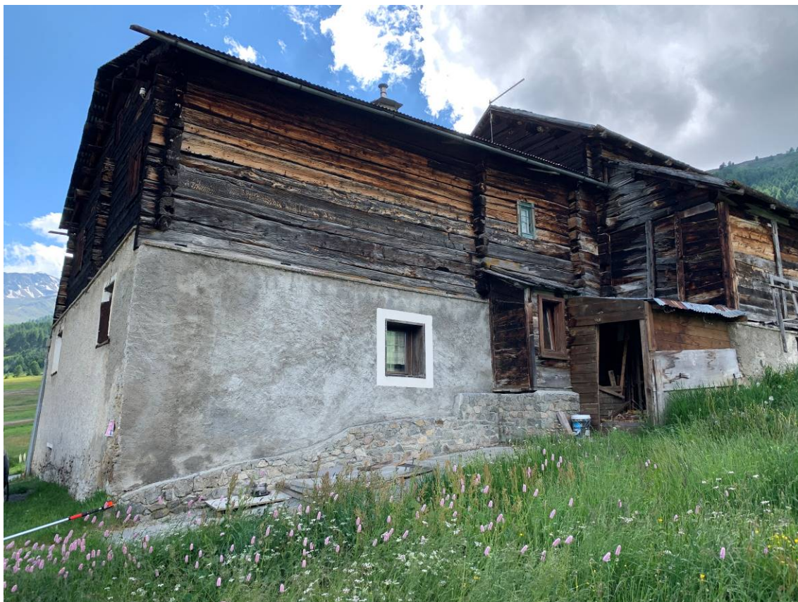
vista da nord del fabbricato oggetto d'intervento
