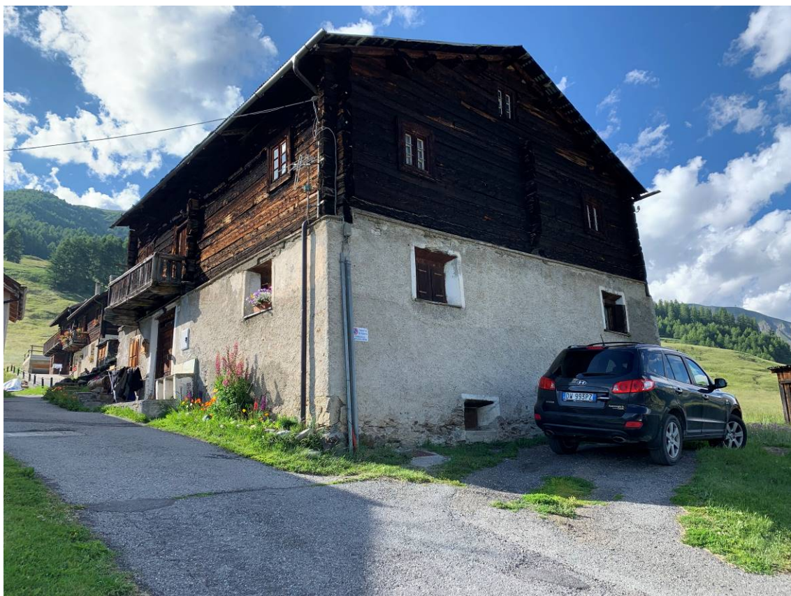
vista da sud-est del fabbricato oggetto d'intervento
