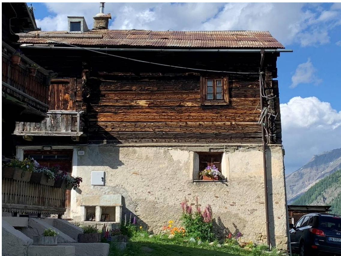
abbaino e manto di copertura in lamiera esistenti
