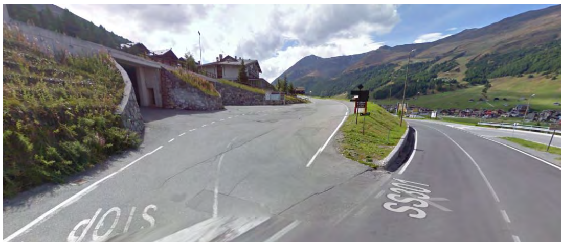
Figura 39 – L'innesto della Via Gerus sulla SS 301 del Foscagno; si osservino gli accessi agli spazi interrati sotto alla funivia Teola-Pianoni Bassi
