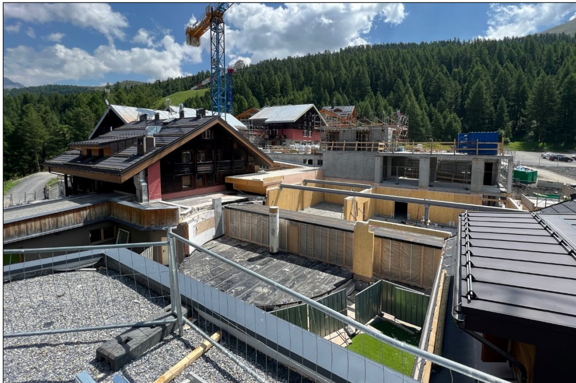
Foto.6- Vista volumi centrali in corso di realizzazione.
