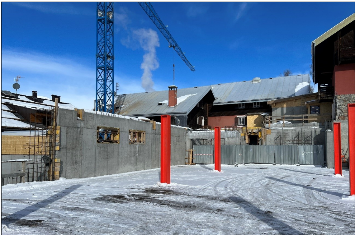
Foto.4- Terzo livello dell'autorimessa in corso di realizzazione.
