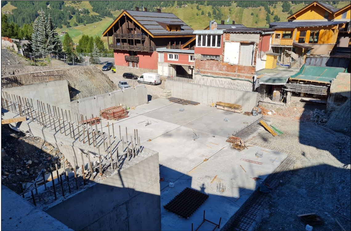
Foto.1- Vista generale della nuova autorimessa interrata.
