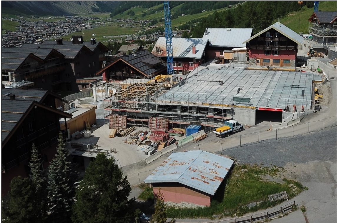
Foto.5- Vista generale della porzione di progetto in corso di realizzazione.
