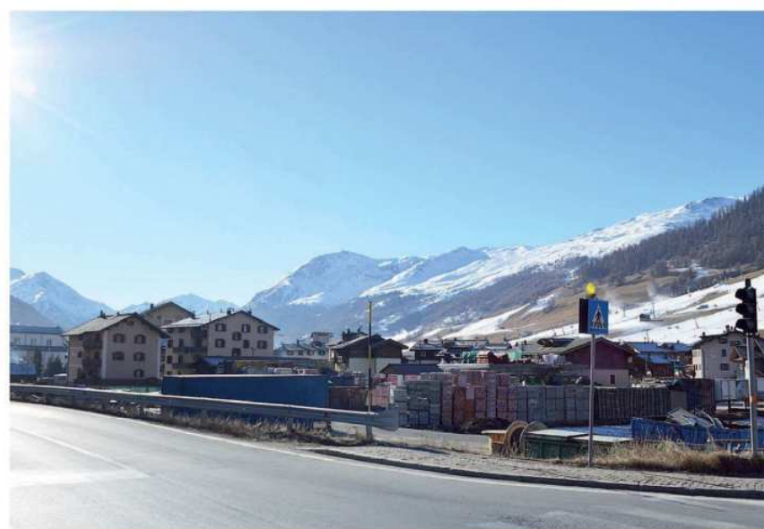
STATO DI FATTO VISTA NORD (1)
